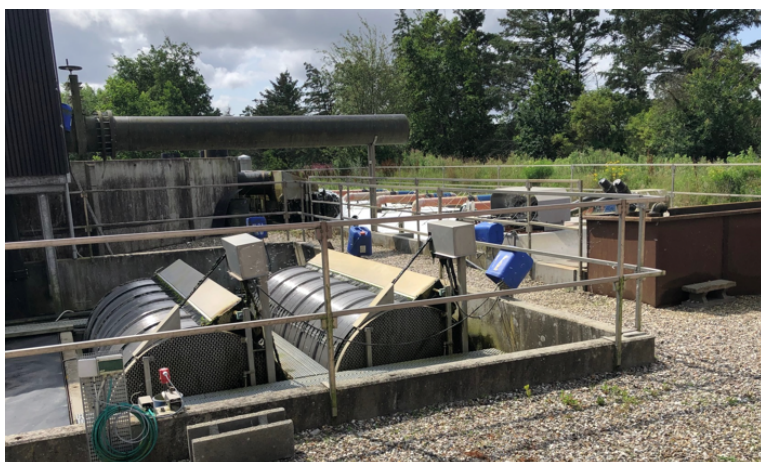
Figur 5. Mikrosigter i vandrensningsenhed knyttet til hus 4.
