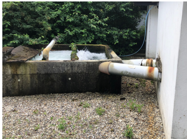
Figur 2 Indretning af Hus 2 med yngelkummer (højre) og afgang af afløbsvand til venstre.
