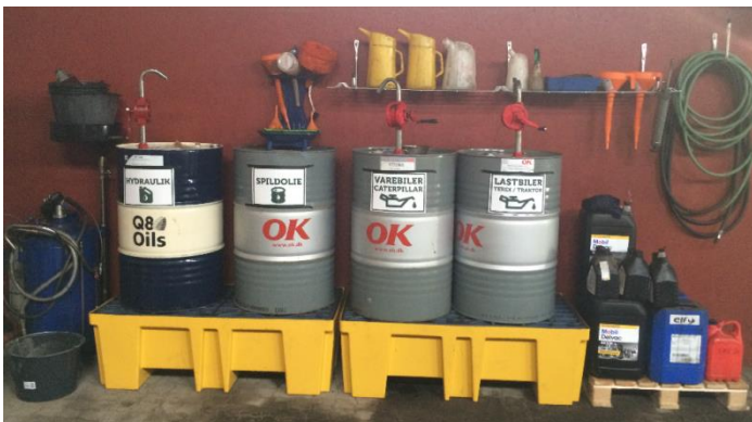
Korrekt opbevaring af spildolier på spildbakke.
