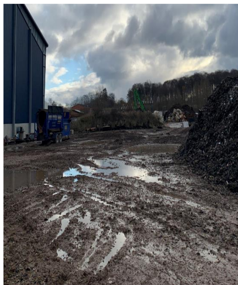
Ubefæstet areal med mange affaldsrester kørt ned i underlaget.
