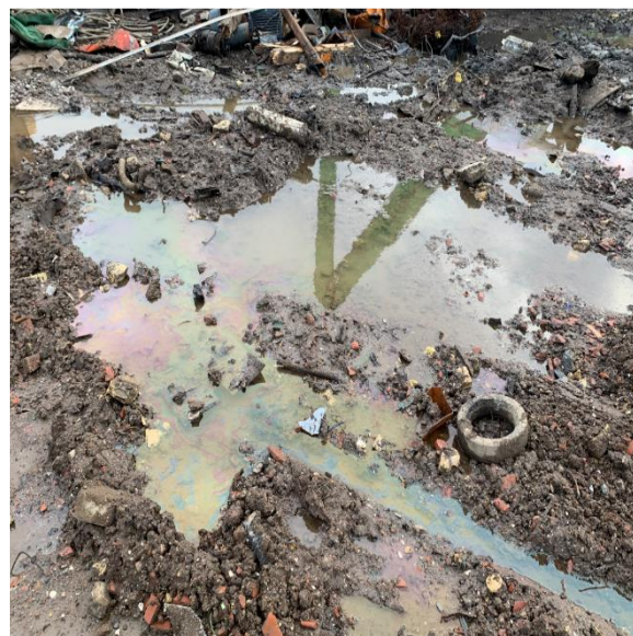
Oliefilm på overfladevand på belægning ved 'Trekanten'.
