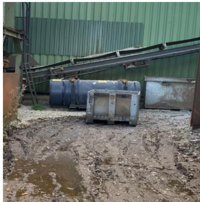
Endnu en tank ikke sikret mod påkørsel. Fremgår af spor i mudder, at der er kørsel på arealet i umiddelbar nærhed af tanken.
