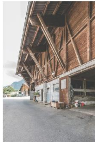
Træfacade med store bjælker og spær
