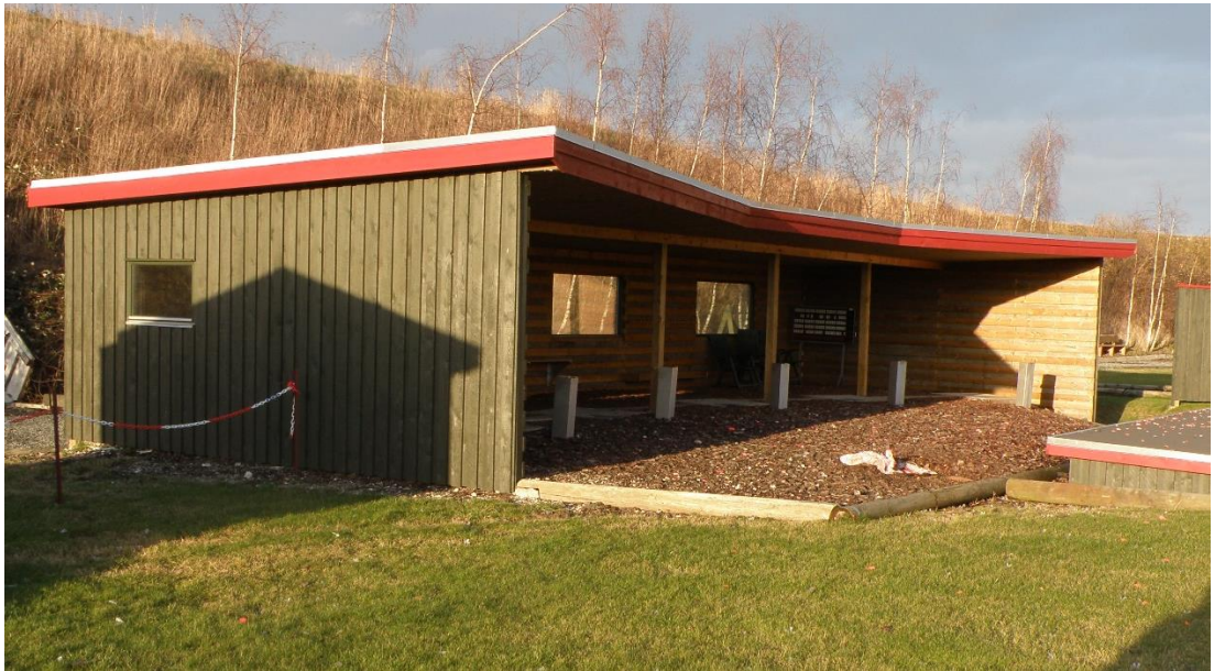
Billede 3: Type Z støjisoleret skydehus på en sportingbane. Skydehuset på Skjern Flugtskydningsbane vil være med frembygget sidevægge min. 2,5 meter fra geværmunding. (DJ-arkiv foto)
