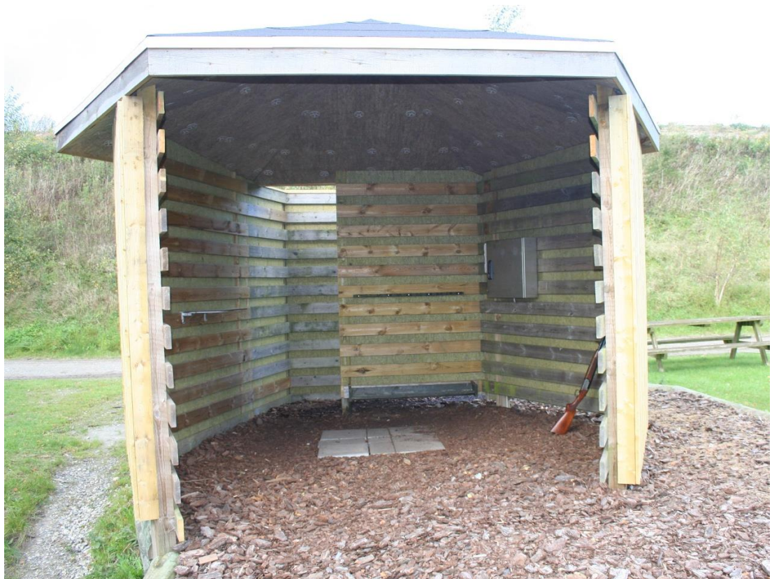
Billede 2: Type Z støjisoleret skydehus fra en anden skydebane. Skytten står på flisen og skyder. Skydehusene på Skjern Flugtskydningsbane vil være med frembygget væg min. 1 meter fra geværmunding. (DJ-arkivfoto)
