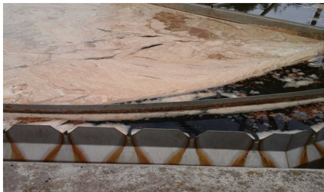
Renseanlæggets efterklaringstank.
