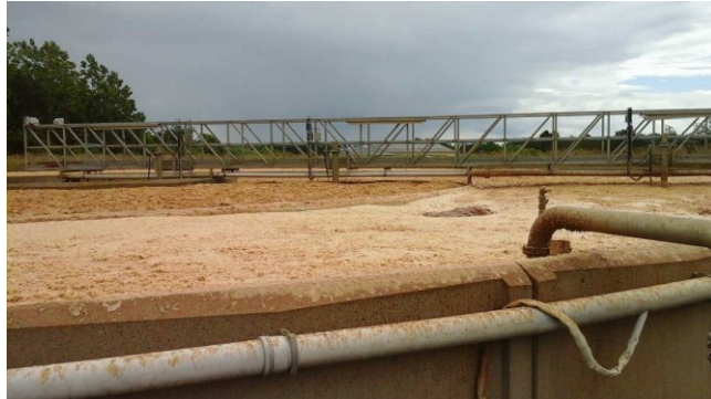
Renseanlæggets beluftningstank.
