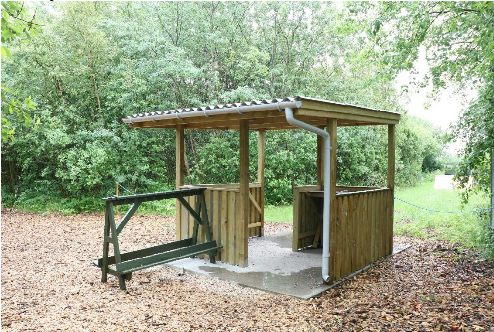
Billede 3: overdækning bag standpladser på jagtbanen.
