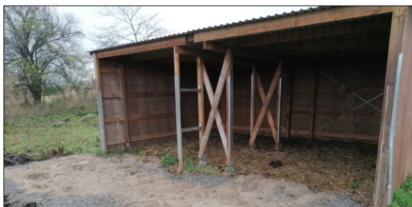
Foto af eksisterende læskur
