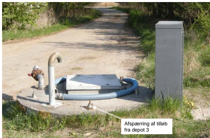
Figur 4.15 Dæksel på Ventilbrønd.
