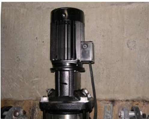
Figur 4.20 Tanktømmepumpe TP02.
