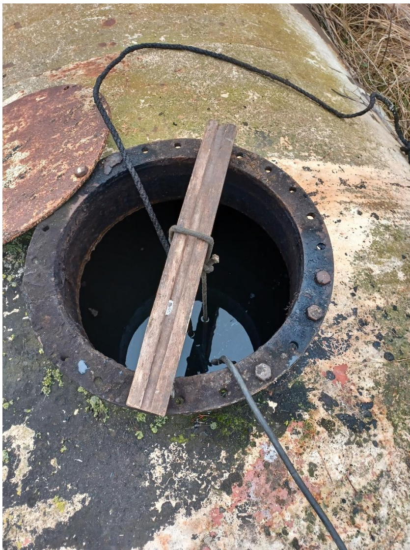
Billede 3 Dykmåler monteret i perkolattanken.
