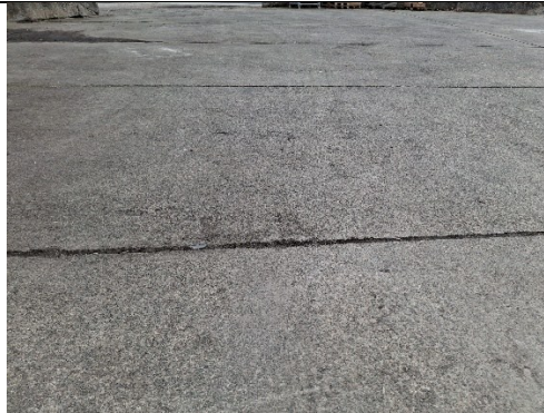
Billeder fra belægning kemikalieopbevaringsplads
