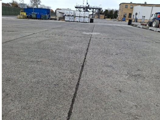
Billeder fra belægning kemikalieopbevaringsplads
