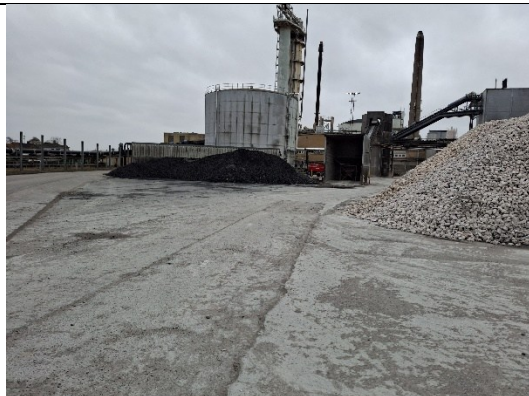
Seinders og kalksten foran læsseporten til disse der fører der videre imod damptrørrer
