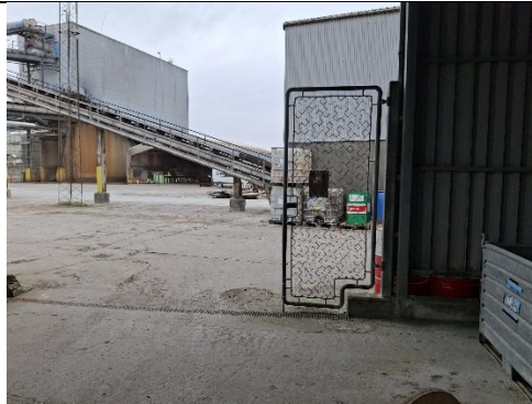
Kig ud fra kemikalie/oliebevaringsbygning.
