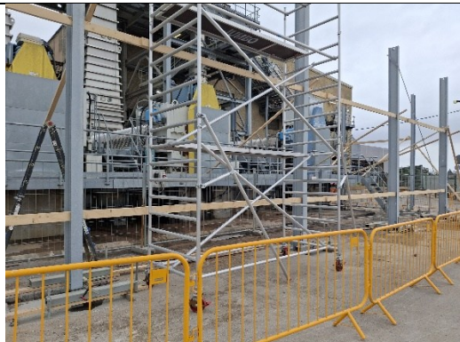
Etablering af støjskærm ved pulppresserne.
