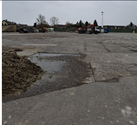
Belægning og jordbunke på opbevaringsplads syd på fabrikken
