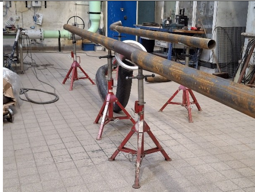
Rør til ny startventil der er afprøvet og klar til montering
