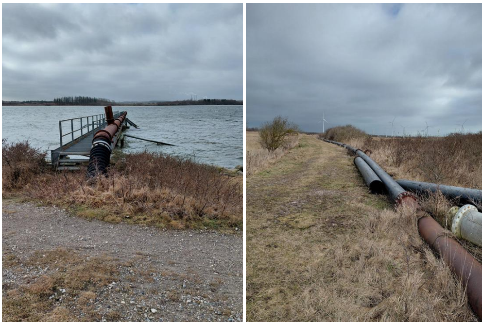
Foto 2. Til venstre: Anlæg til indspuling af sediment fra pram via anløbsbro. Til højre: fast rørledning til landfelterne.
