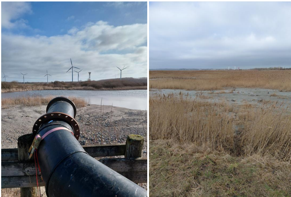
Foto 3. Til venstre: Deponering ved indspuling i Landfelt Øst. Til højre: Tidligere deponering i Vandfelt Vest.
