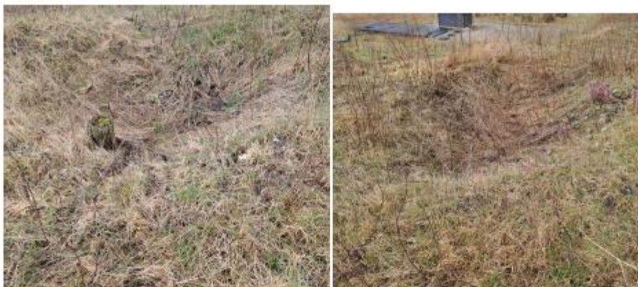
Figur 3 To større sætninger i deponiet.
