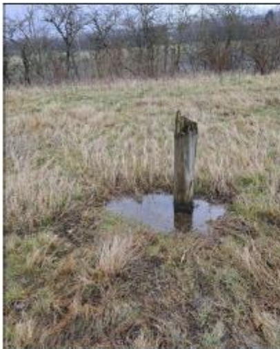
Figur 2 Tv. Stillestående vand ovenpå deponiet. Omkring pælen er slutafdækningen sunket omkring 70 cm. Th. Erosion af slutafdækningen langs skrænten ned mod pumpehuset. Formodes at skyldes større regnhændelser.
