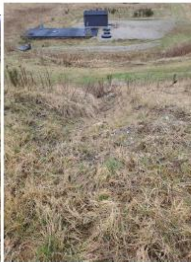
Figur 2 Tv. Stillestående vand ovenpå deponiet. Omkring pælen er slutafdækningen sunket omkring 70 cm. Th. Erosion af slutafdækningen langs skrænten ned mod pumpehuset. Formodes at skyldes større regnhændelser.
