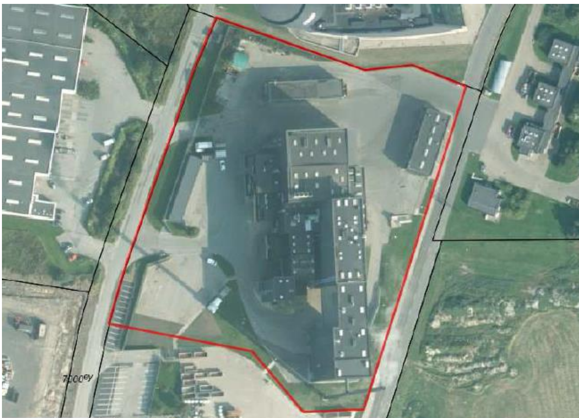
Luftfoto af AVV affaldsforbrændingsanlæg, sommeren 2016. I den sydligste tilbygning findes det nye røggaskondenseringsanlæg ved siden af ny skorsten.
