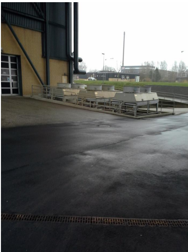
Ny asfaltbelægning ved restproduktsilo
