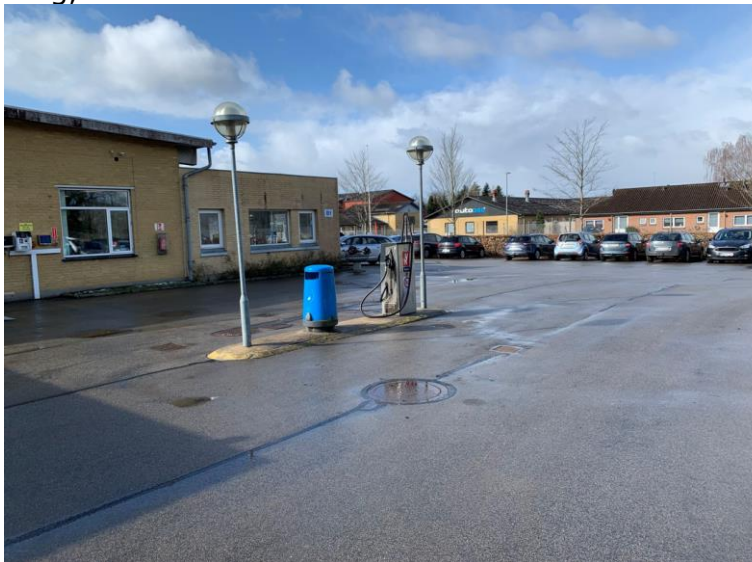
Tankningsplads for dieselolie med asfaltbelægning
