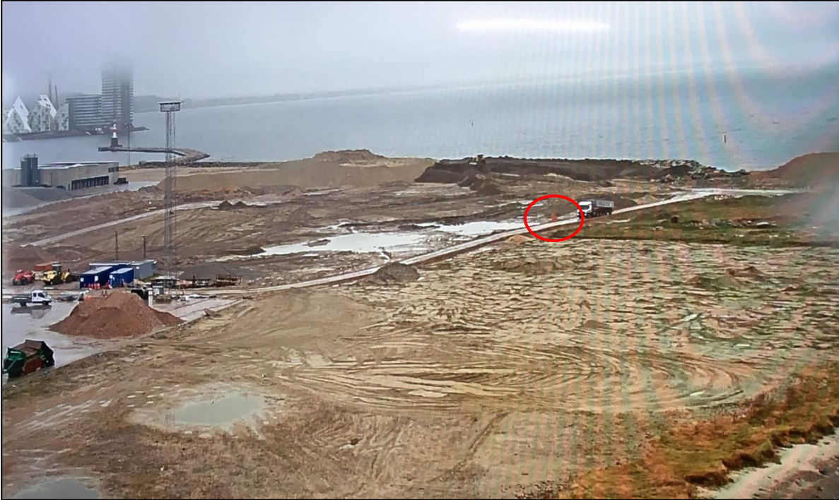
Foto 6 fra tilsynet 6. april 2022 af prøvebrønd B2 på Oliehavnen.
