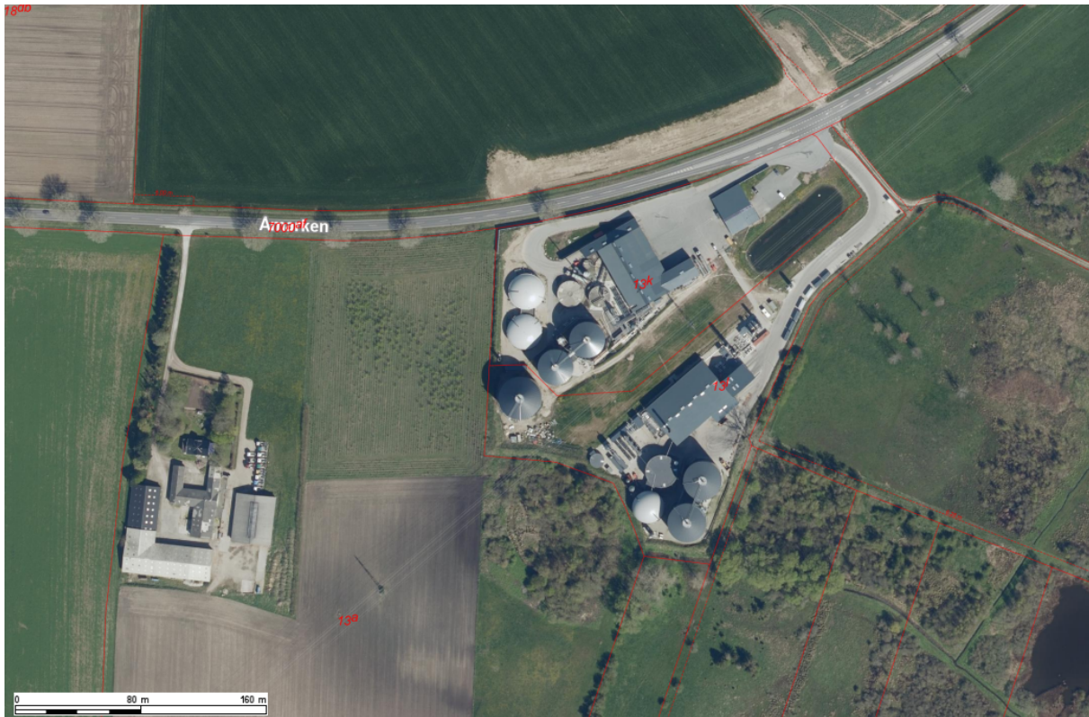
Figur 2: Adgangsvej til biogasanlæggene fra Åmarken og nærmeste nabo vest for biogasanlæggene.
