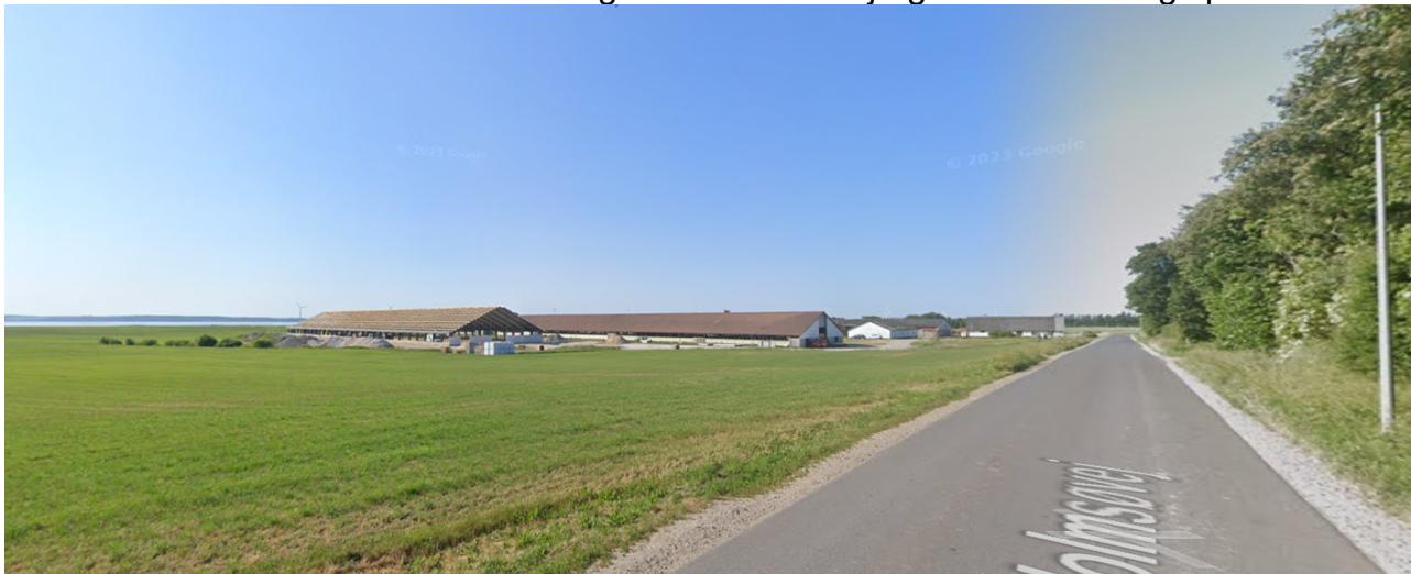
Figur 1 Ejendommen Holmsøvej 78 - Ligger lige syd for Holmsøvej 93 og ligger helt frit i landskabet.
