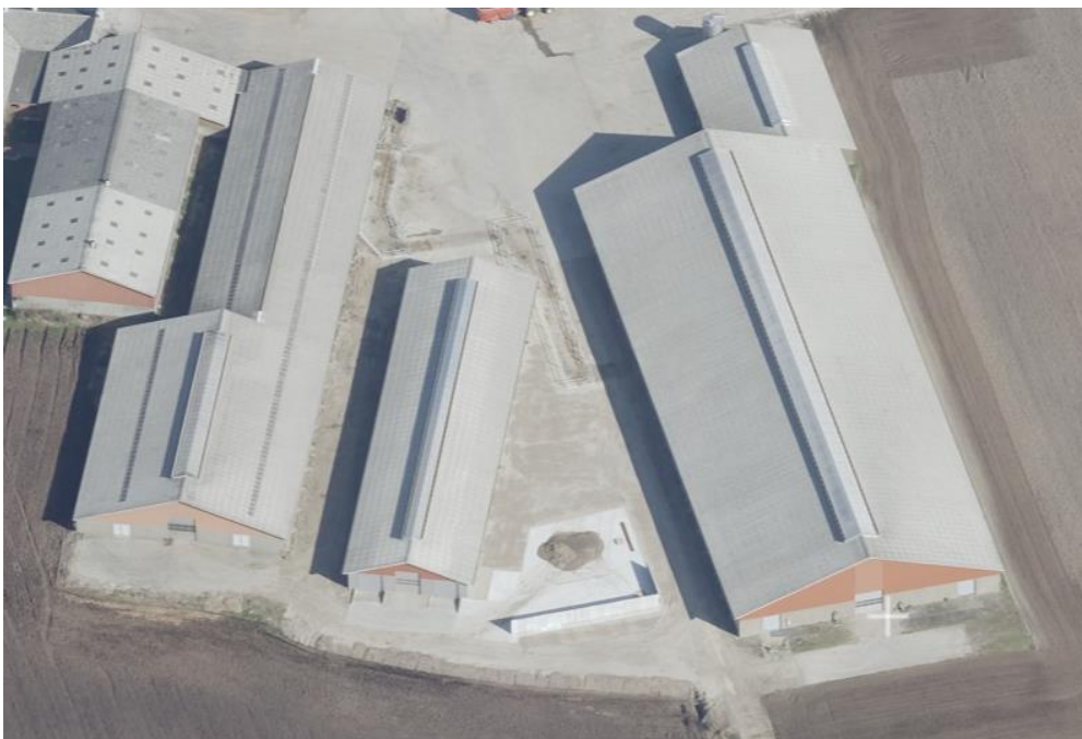
Kort 4. Skråfoto, der viser bl.a. eksisterende kostalds byggestil, materialer og farvevalg
