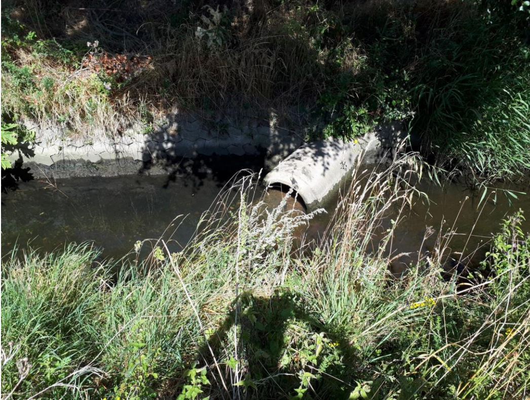
Udløbet, hvor det tidligere er afledt kølevand.
