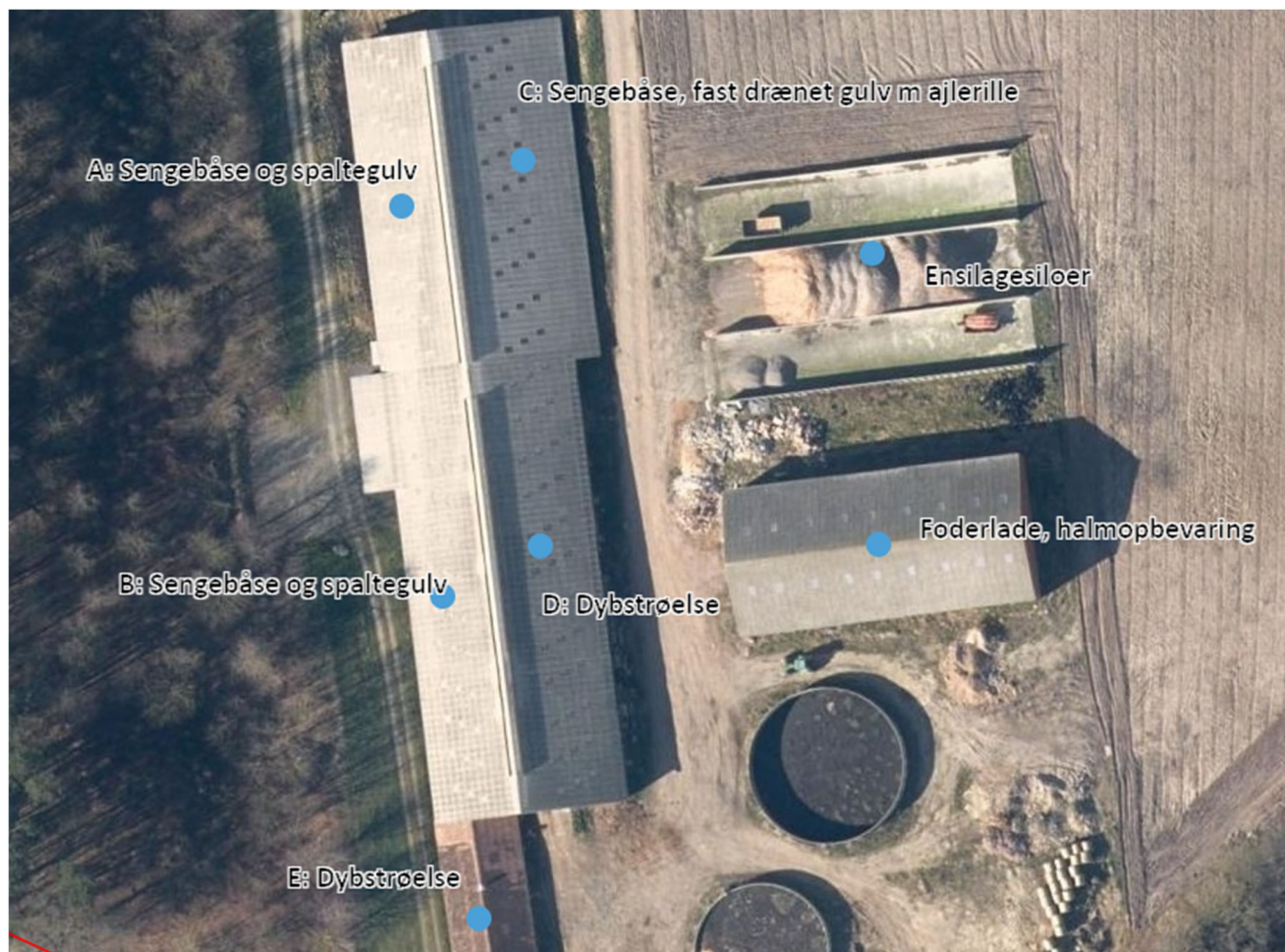
Figur 5 Anlægget på Munkhøj, Kilde: Ansøgningsmaterialet.
