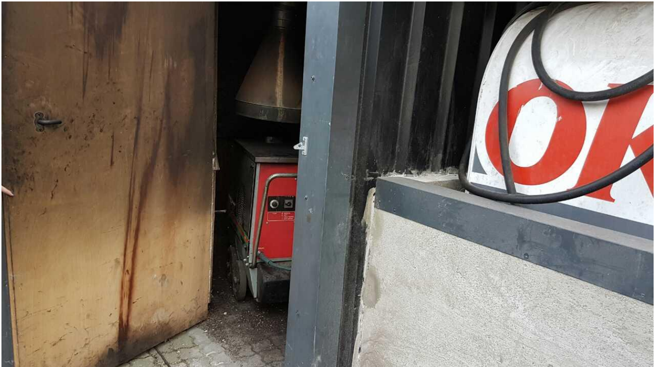
Dieseltank med betonkar ses til højre. I tilstødende skur til venstre står hedtvandsrenseren.
