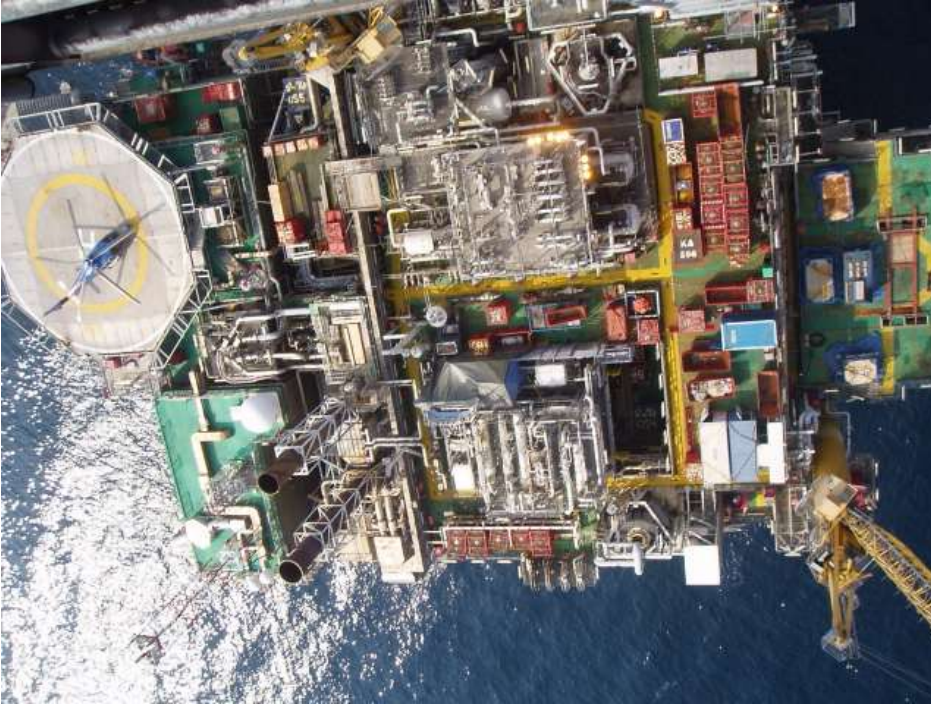
Figur 6-1 Turbinens skorstene set fra flaretårn. Den sydlige skorsten er røggas fra turbinen og den nordlige skorsten er til varmeledning fra generator enclosure.
