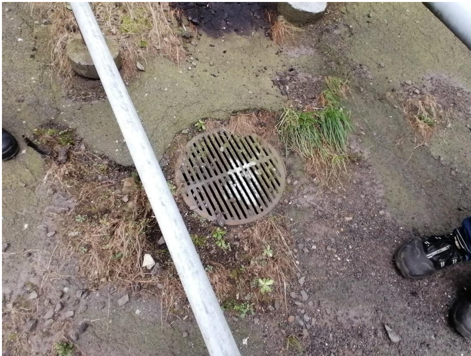
Afløb og belægning i tankgård med tank 1,2 og 3.
