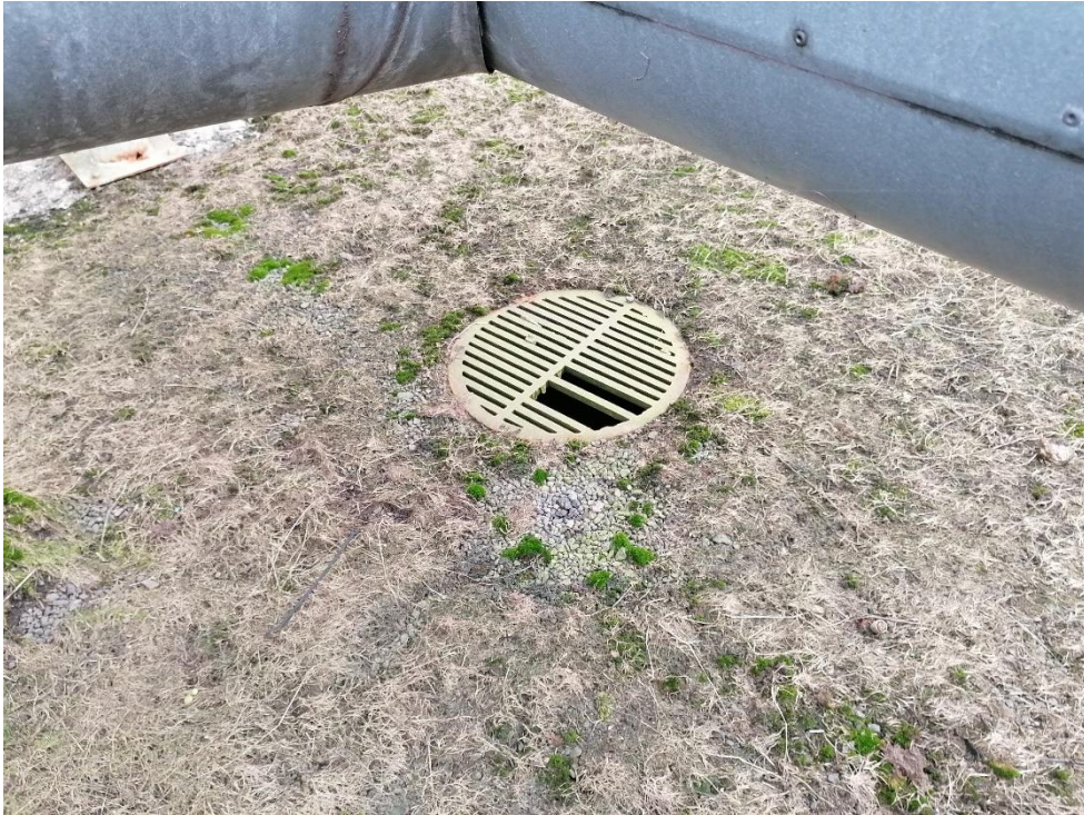
Afløb og belægning i tankgård med tank 4, 5 og 6.
