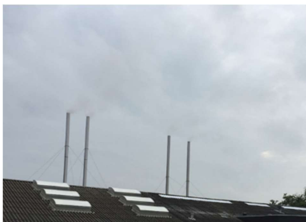
Foto af afkast fra den 26.9.2017 – røgen har et meget svagt løft.
