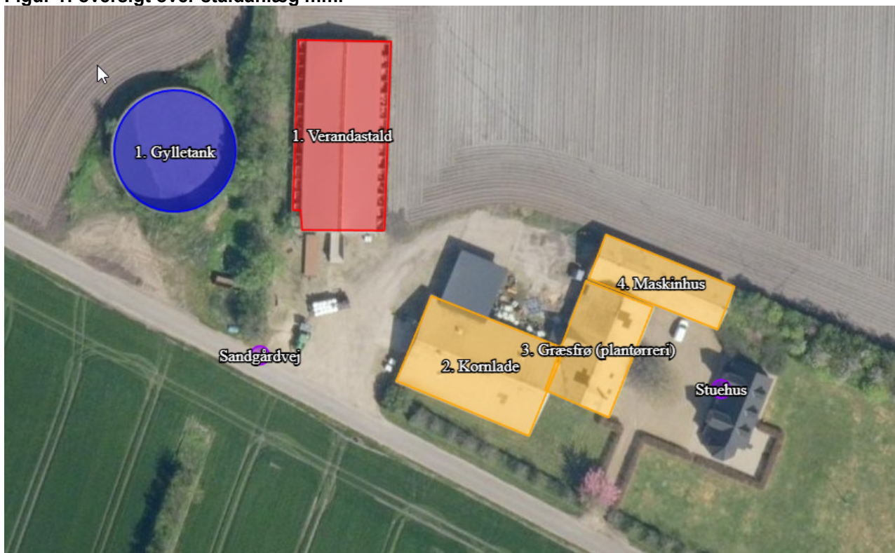
Figur 1: oversigt over staldanlæg mm.
