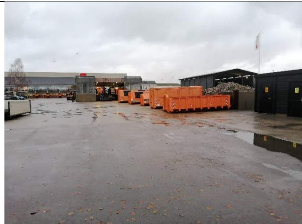
Foto 16. Pladsen med minimum 5 containere
