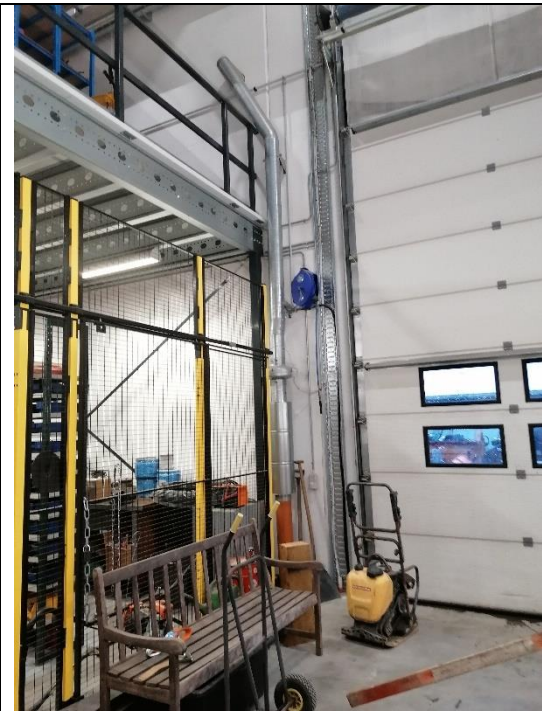
Foto 9. Udsugning fra graven
