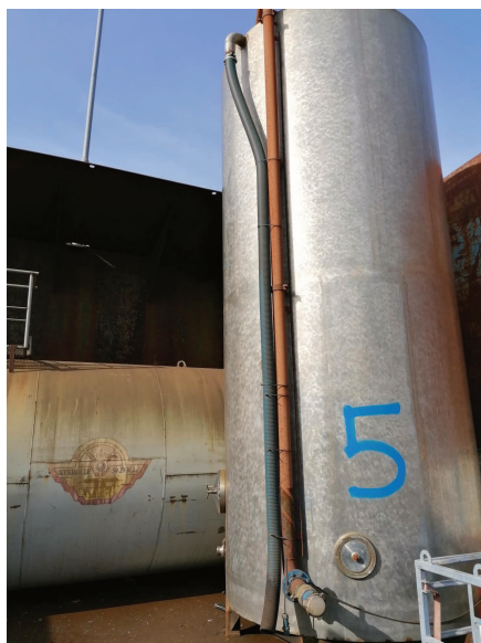
Buffertank samt tank, der ikke er i drift
