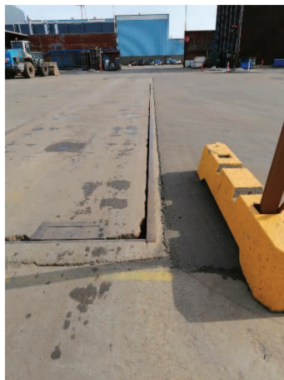
Udbedring af belægning.
