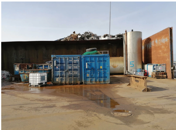
Containere med overfladevandsbehandling
