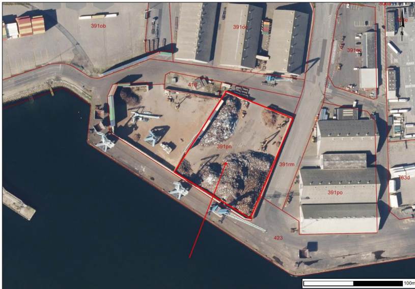
Figur 4 Oversigtskort over pladsen på Centerhavnsvej 12.
