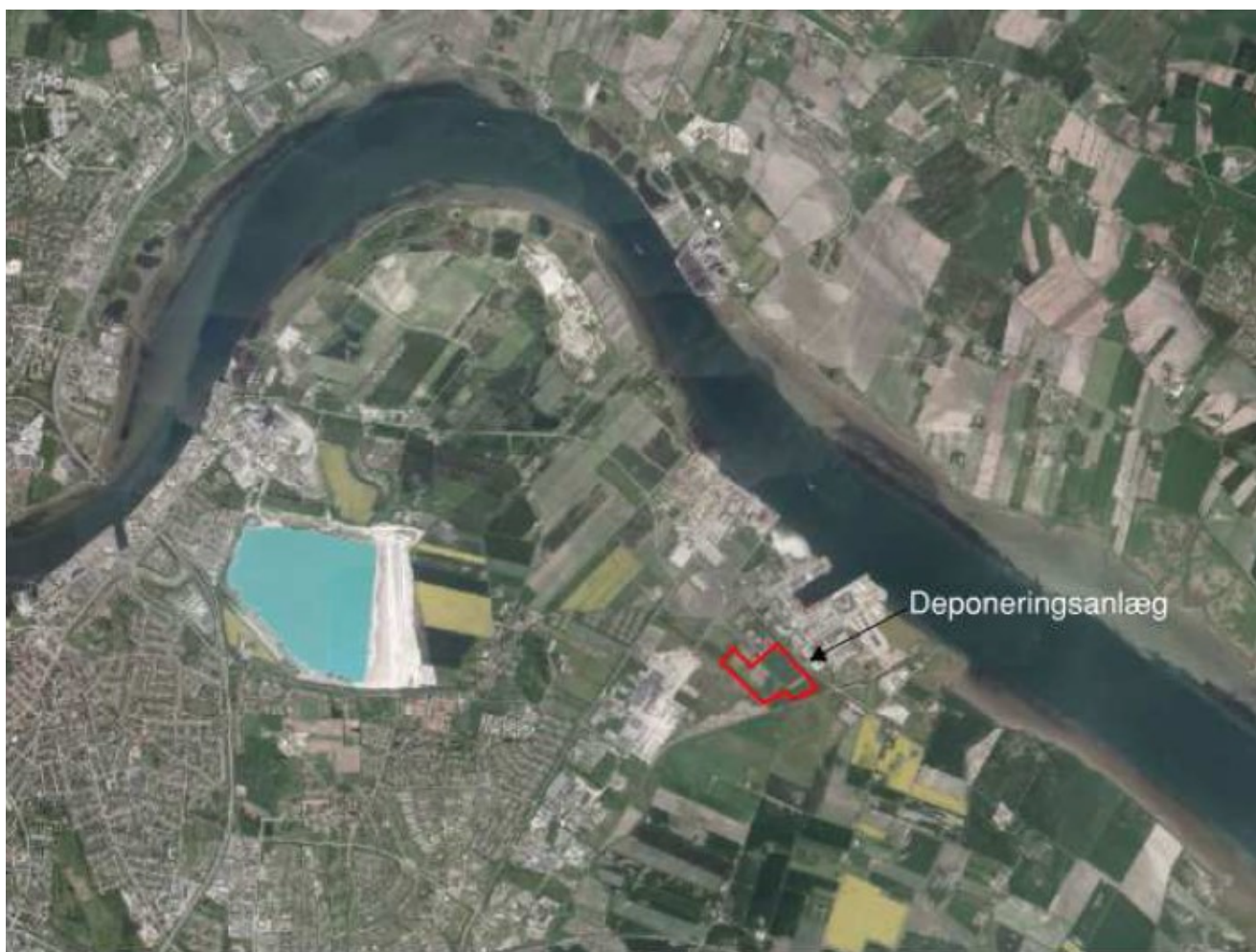
Deponeringsanlægget ved Renseanlæg Øst er beliggende i den østlige del af Aalborg. Deponiet er indtegnet med rødt. Billedet stammer fra Aalborg Forsyning, Kloak A/S' Overgangsplan, Slamudlægningsareal på Renseanlæg Øst og udarbejdet af COWI. Målestok ca 1:40.000
