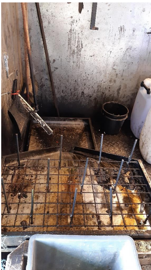
Figur 5. Bygning til farligt affald. Øverst: Kig ind i bygningen. Nederst tv: Bakke og tragt til spildolie. Sump er placeret under kørepladen. Midterst th: Alarm udenfor porten til bygningen til farligt affald. Nederst th: container til malerester.
