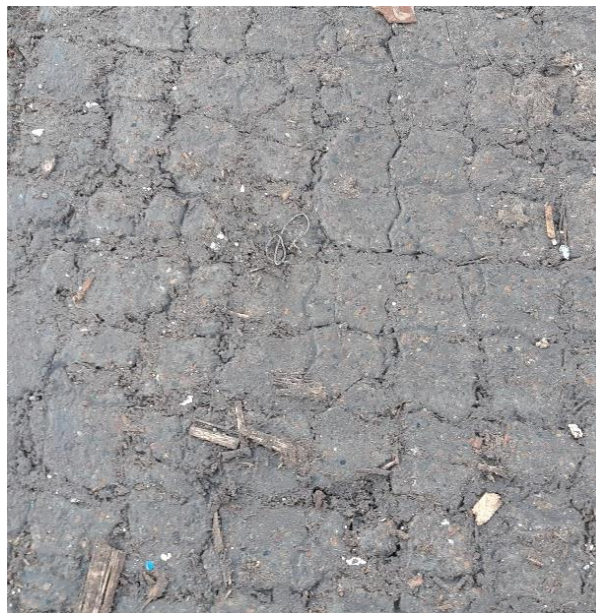
Figur 8. Oplagsplads for genanvendelige materialer. Øverst: oplag af neddelt tryktræ. Midterst: Plast fra genbrug og industri. Nederst tv: Området har hældning mod afløb midt på pladsen. Belægningssten på pladsen var nogle steder nedbrudte.
