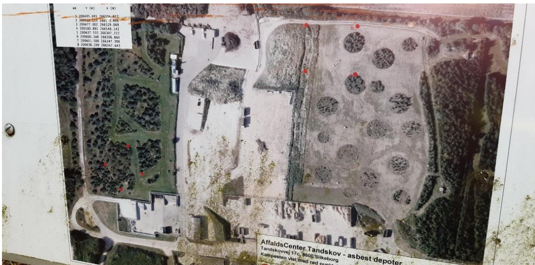
Figur 2. Deponeringsanlæg. Øverst: Biocover i den østlige del af afdeling 4.1. Midterst tv: Vissen plantevækst på biocover. Midterst th: Kampesten samt skilt i hjørne af asbestområde. Nederst: Udsnit af skilt ved asbestområde.
