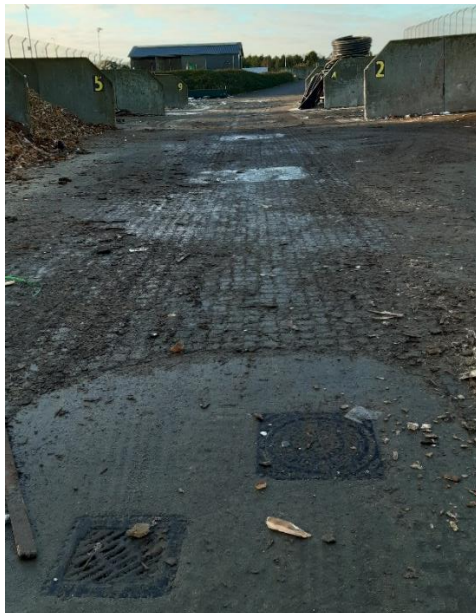
Figur 8. Oplagsplads for genanvendelige materialer. Øverst: oplag af neddelt tryktræ. Midterst: Plast fra genbrug og industri. Nederst tv: Området har hældning mod afløb midt på pladsen. Belægningssten på pladsen var nogle steder nedbrudte.
