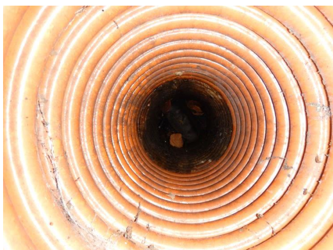
11. Gennemløbsbrønd på 160 mm afløbsledning fra oleudskiller til regnvandsledning/rørlagt vandløb
