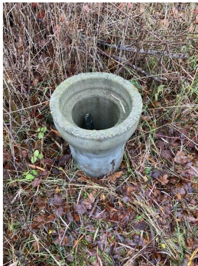
Alle 7 boringer på deponiet er omkranset af betonrør.
