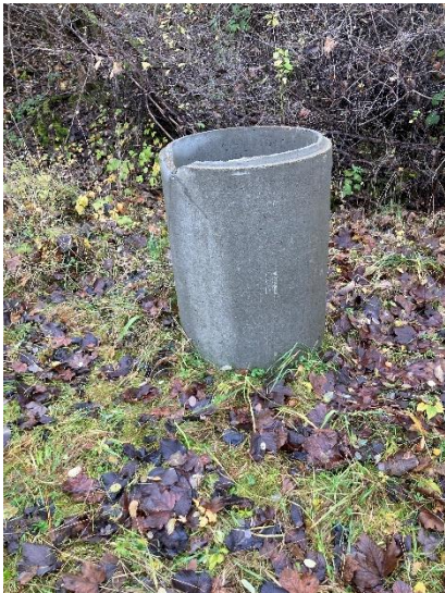
Alle 7 boringer på deponiet er omkranset af betonrør.
