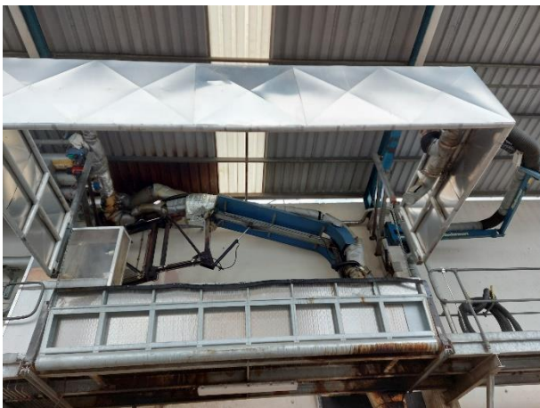
Figur 1. Ekstra skærm og afsugning ved domdæksel
