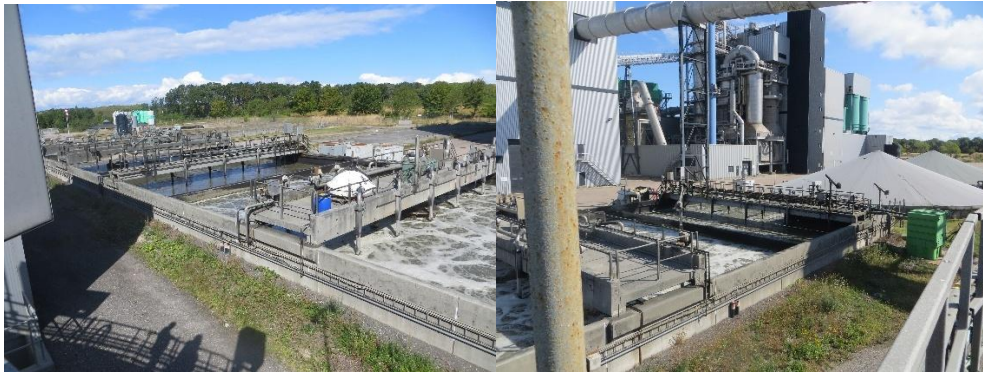
Gamle procesanlæg tank 51.01, 52.01, 52.02, 52.03 og 52.04
