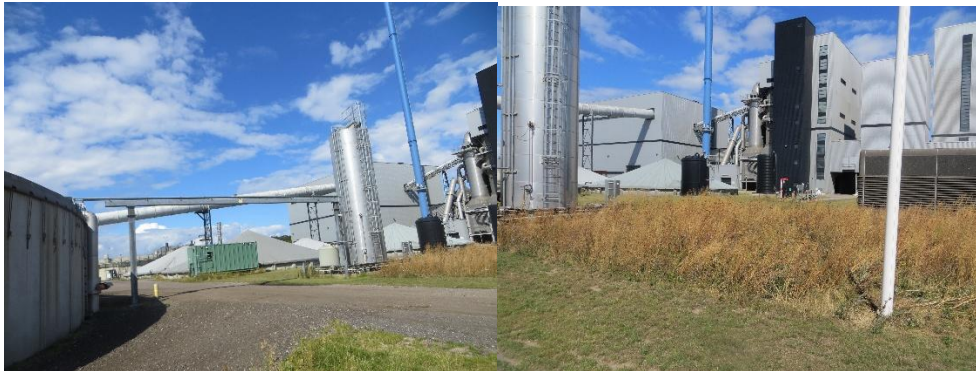
Til venstre; rørbro som IWS oplyser var en del af årsagen til spildet.
