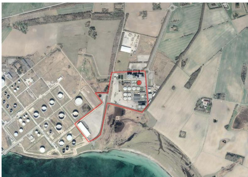
Ortofoto IWS med renseanlæg, nye og gamle slamplads samt matrikel 1K
