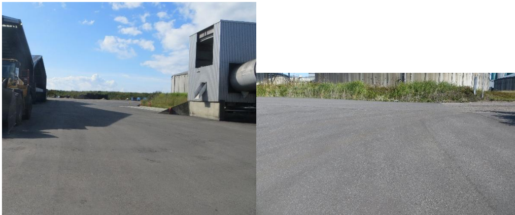
Ny belægning uden for Hal A
