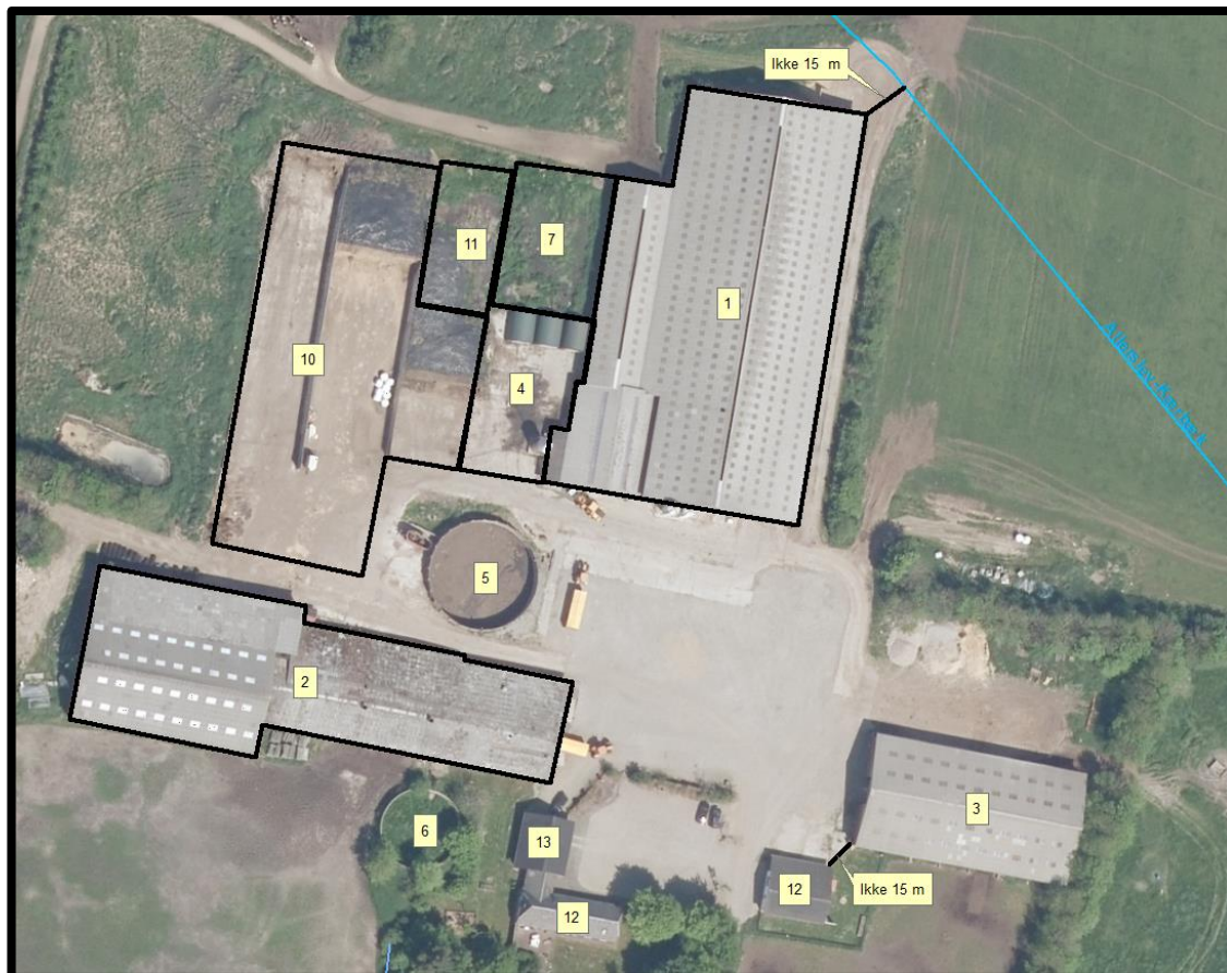
Figur 3. Manglende overholdelse af afstandskrav.
