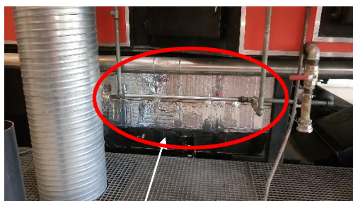
Billede nr. 1: Forbedring på halmkedlen, så risikoen for dannelse af slagter reduceres (2022)
