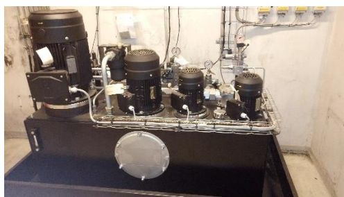
Billede nr. 2: Ny hydraulikstation (2022)
