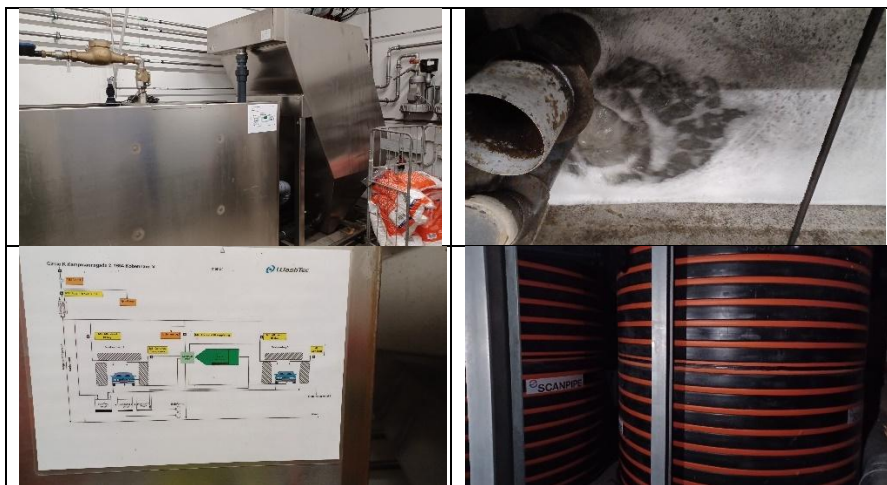
Principskitse på biologisk rens af spildevand til genanvendelse samt af biobeholderne nede under jorden.
