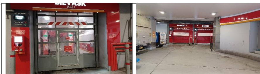
Der er 3 vaskehaller placeret inde i bygningen.
