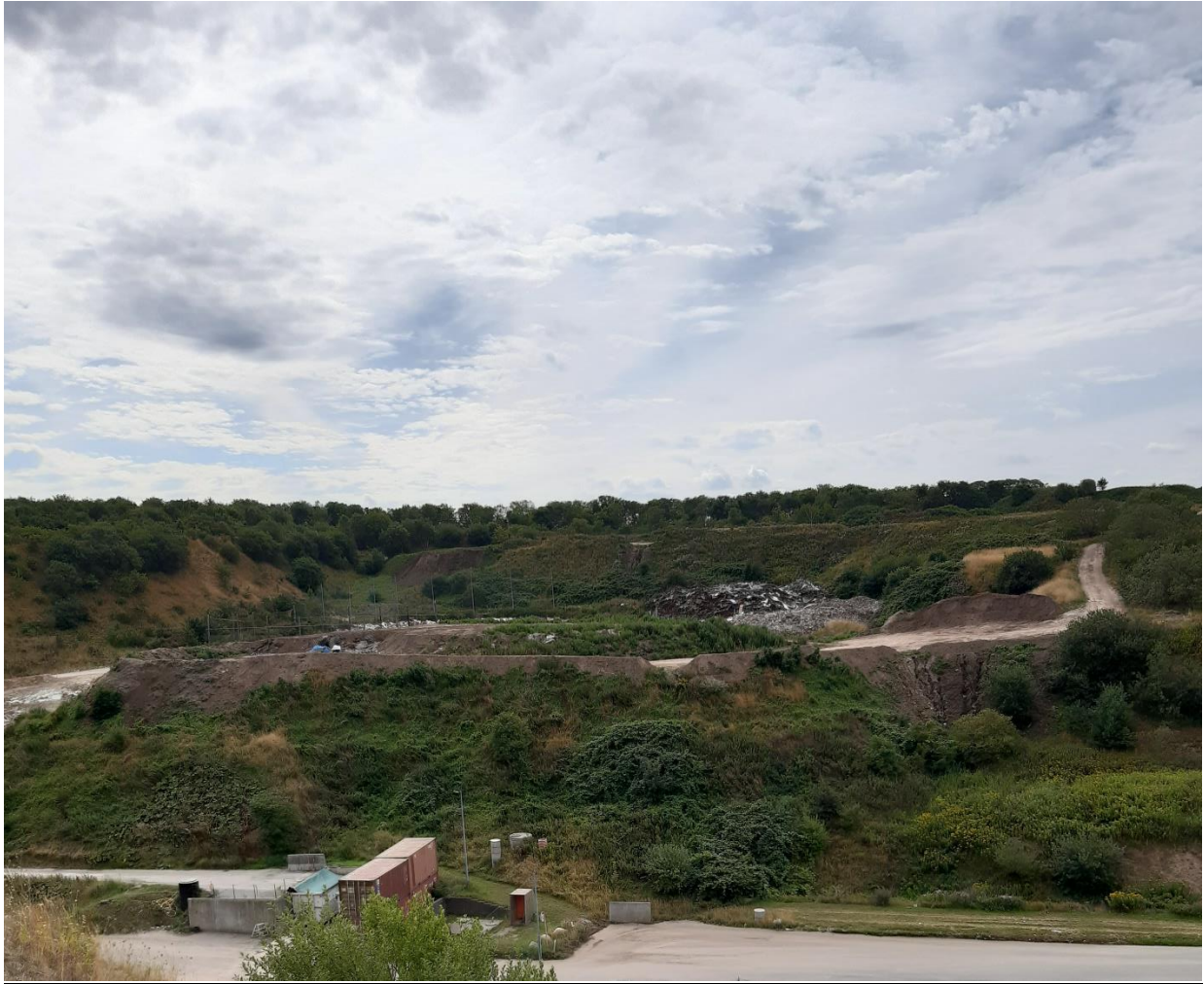
Figur 3 hævede skrænt ved enhed 4.2.1 til asbest.
