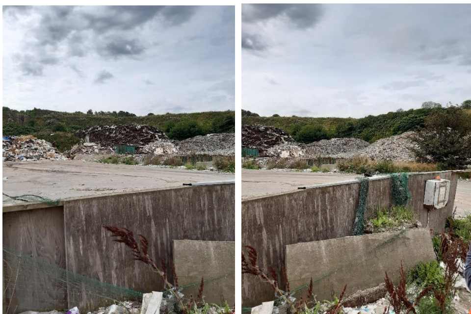
Figur 15 Ikke tilladt oplag af rent og trykimprægneret træ på etape 4.1.
