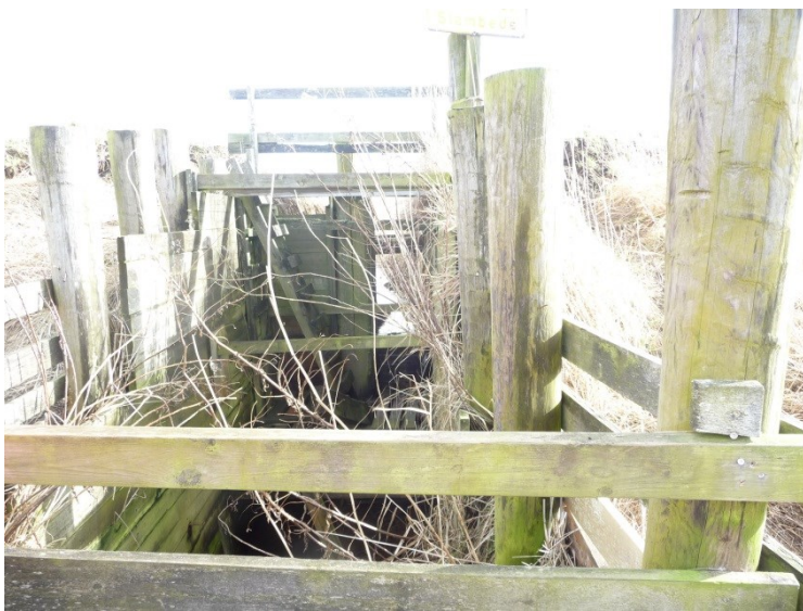
Foto 6: Sluse, der er halvt åben til højre.
