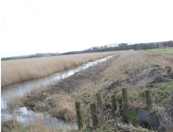
Foto 5. Sluse i nordvestligt hjørne af deponiet ved Stånum Enge. Set mod sydøst.
