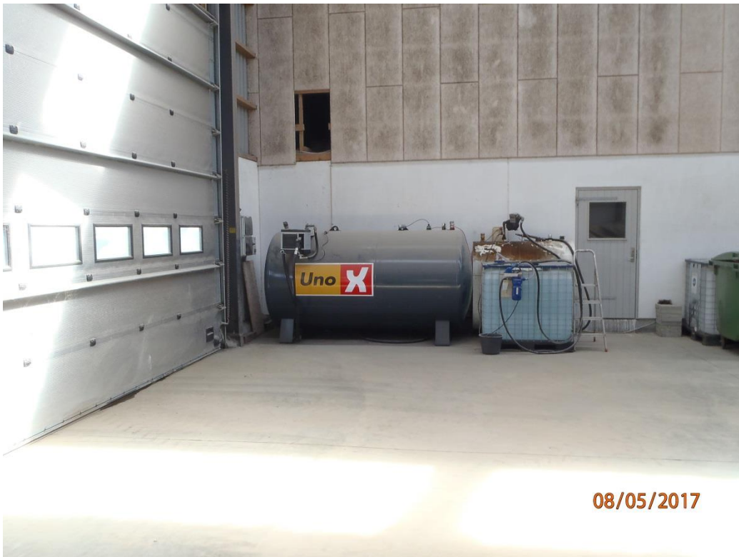
Billede viser dieselolietank på 5000 liter og 1200 liter placeret ved portåbning ved stal- den/foderladen
