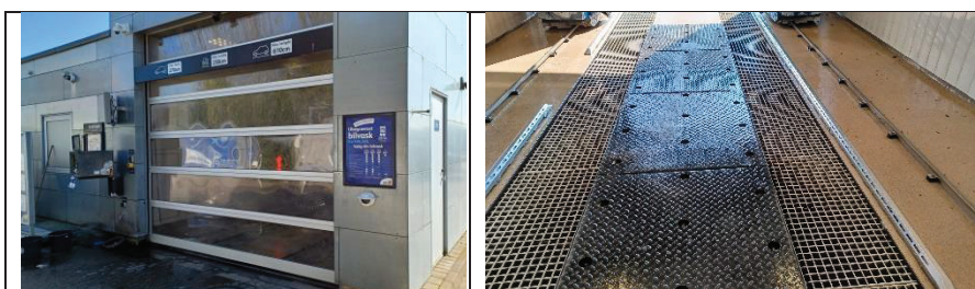
Indkørsel til vaskehal samt indvendigt.
