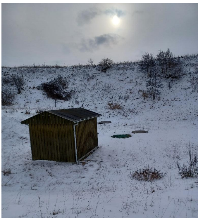
Foto 2. Pumpehuset og perkolatbrøndene fra deponiet der pumper videre til renseanlæg for alle etaper.
