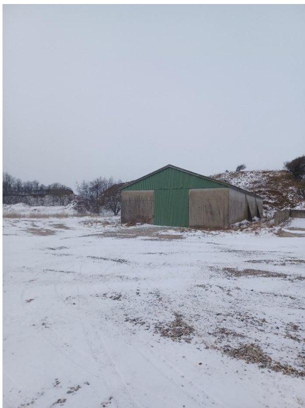
Foto 2. Hallen, det tidligere specialdepot for batteriaffald
