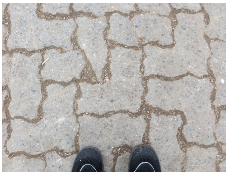
Foto 5 Fast belægning på arealet til stort brændbart
