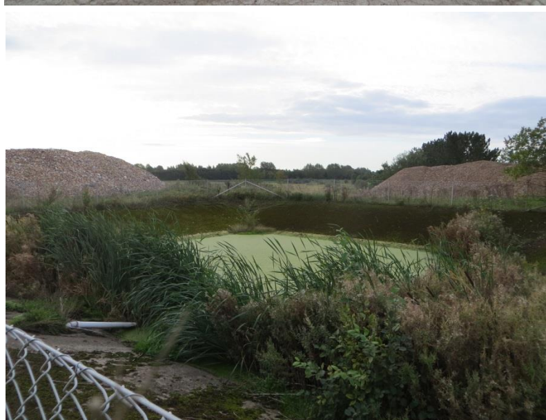
Foto 4 Bassin til overfladevand. Vandet ledes via dræn hertil fra komposteringsanlægget.
