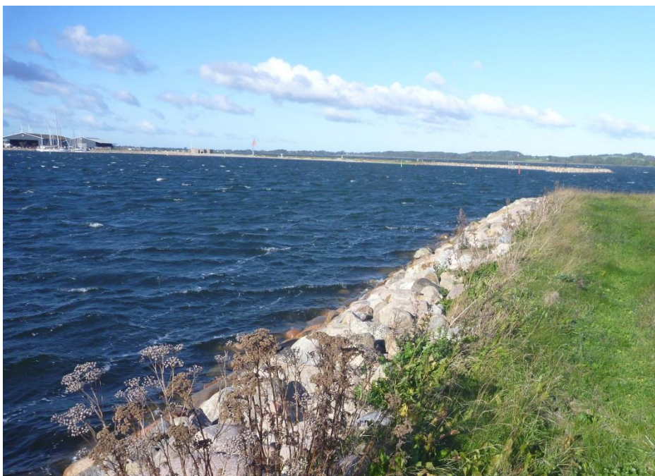
Figur 4. Dæmning omkring deponiet.
