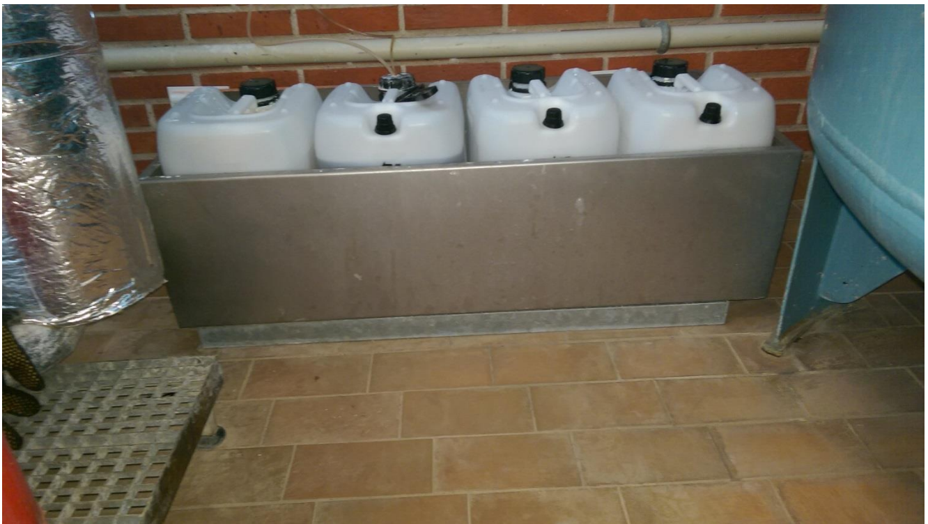
Vandbehandlingskemi opbevares med spildsikring.
