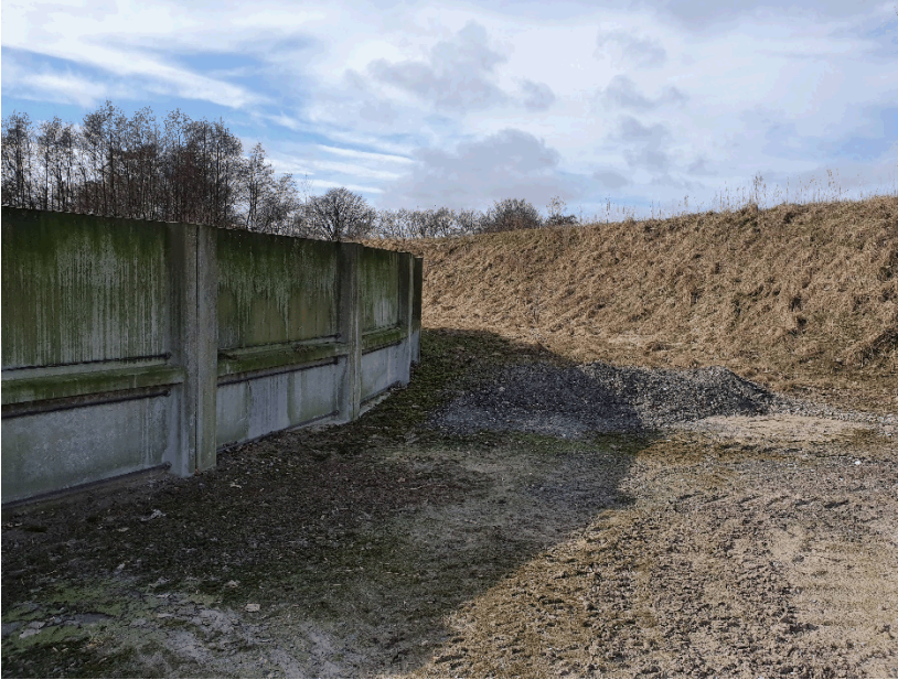
Figur 4 Foto af eksisterende gylletank med bakken i baggrund, hvor der skal udgraves til den nye gylletank.
