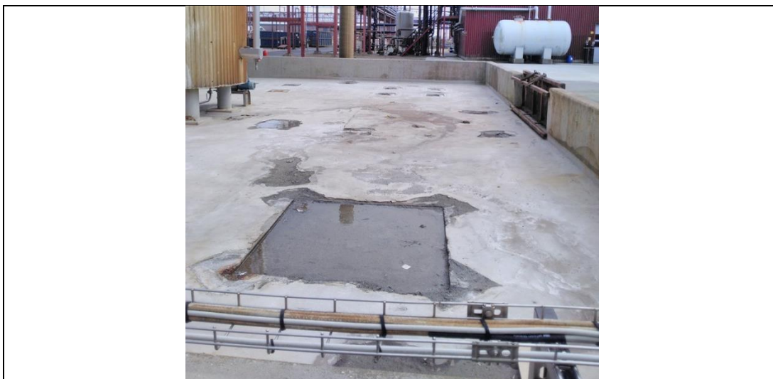
Tankgrav ved DMT efter fjernelse af Azonol-tank.
