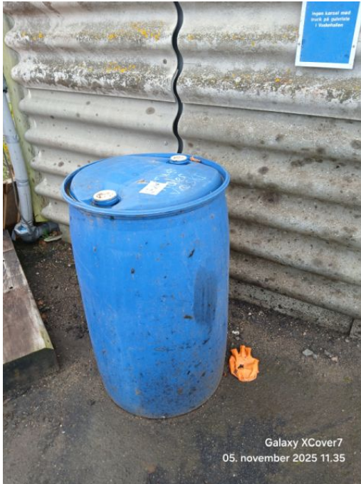
Tønde med brugt kølervæske
