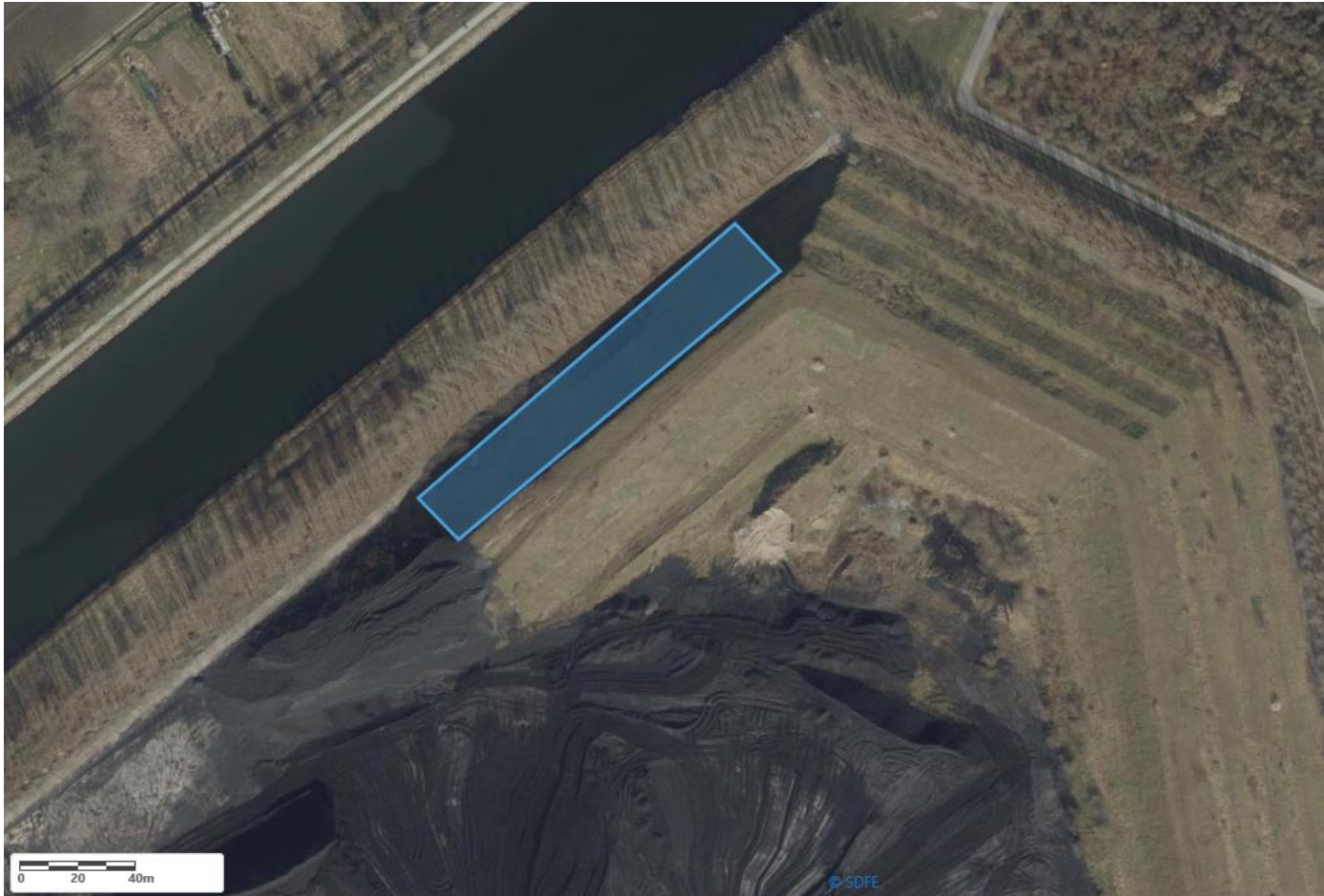
Figur 4 Skitse der viser området for indbygning af jord opgravet på "kulpladsen" ifm. Bio Blok 2. Ved indbygningen stabiliseres jorddækket på ydersiden af den nordlige støjvold.
