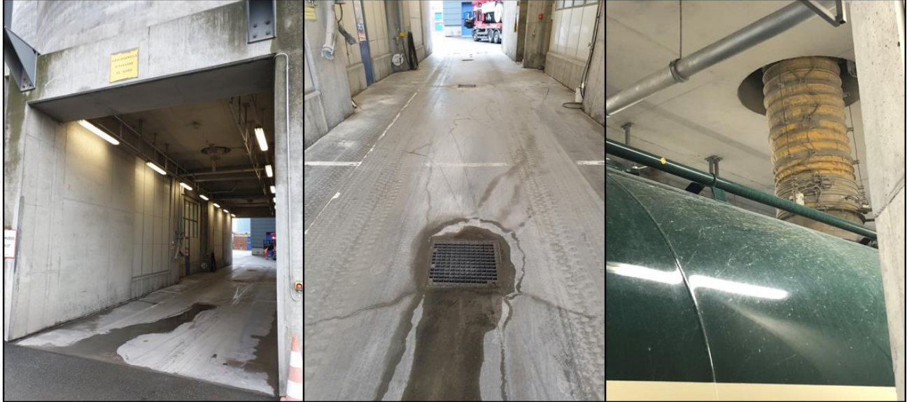
Figur 3.4: Foto fra "Firkløversilo". Venstre: Indkørsel til Flyveaskesilo 20; midt: befæstet areal under silobygning med afløb til Opstuvningsbassin; højre: læsning fra oven af tankbil. Foto: NIRAS 11. maj 2021.
