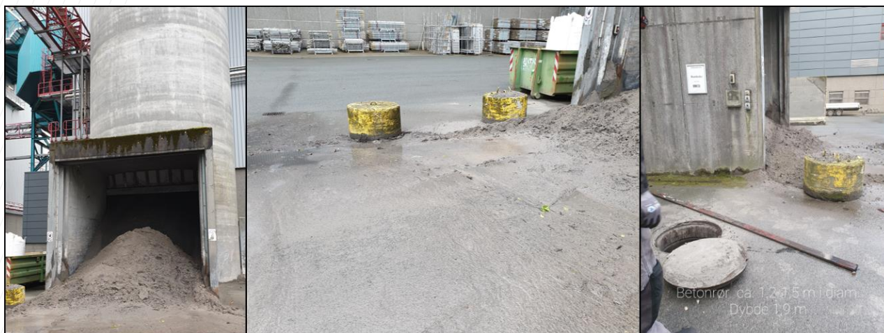
Figur 3.5: Foto fra Slaggesilo. Venstre: silo med åbning; midt: befæstet areal foran siloen med afløb; højre: åbning til samlebrønd. Foto: NIRAS og FFP 11. maj 2021.
